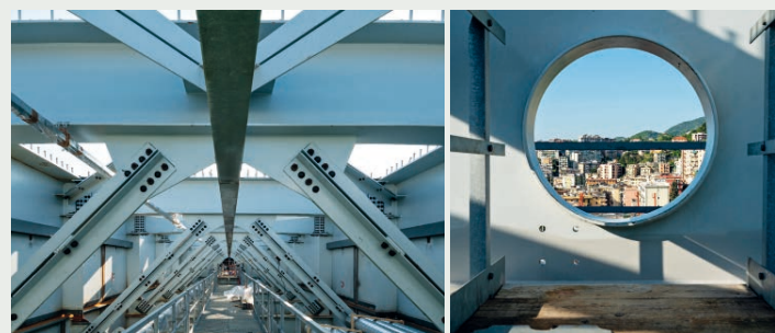
In alto, le alette (bianche) sulle quali saranno montati i pannelli fotovoltaici. Sotto, da sinistra, il corridoio centrale di servizio per il controllo e le ispezioni degli impianti e uno degli oblò di collegamento tra il corridoio e le passerelle laterali
