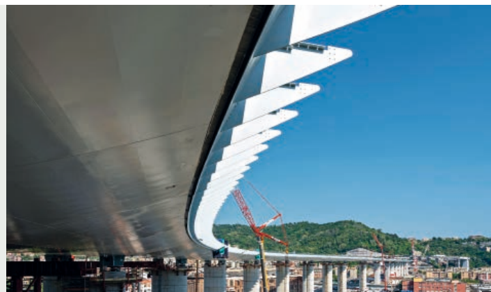
In alto, le alette (bianche) sulle quali saranno montati i pannelli fotovoltaici. Sotto, da sinistra, il corridoio centrale di servizio per il controllo e le ispezioni degli impianti e uno degli oblò di collegamento tra il corridoio e le passerelle laterali
